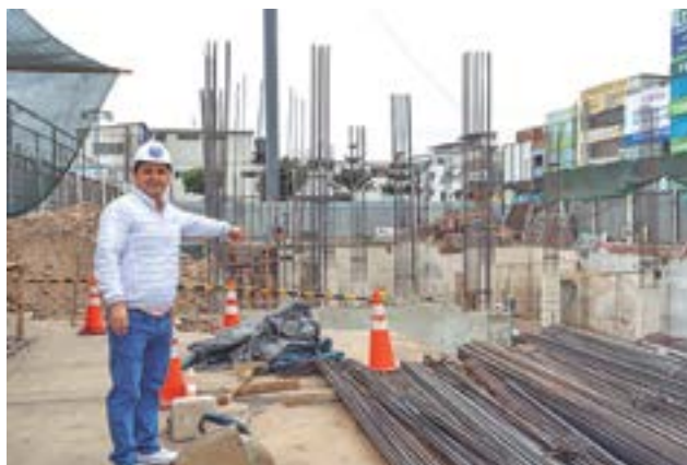
Gran avance de la construcción de la Central de Seguridad Ciudadana.
