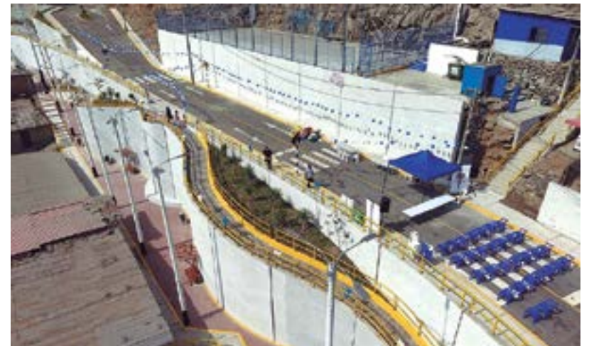
Nuevas pistas, veredas, muros de contención y escaleras en calle Cupisnique.
