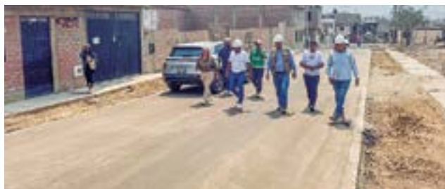
Supervisión permanente del alcalde de Cieneguilla a las obras de construcción de pistas y veredas en la lotización Chávez.
