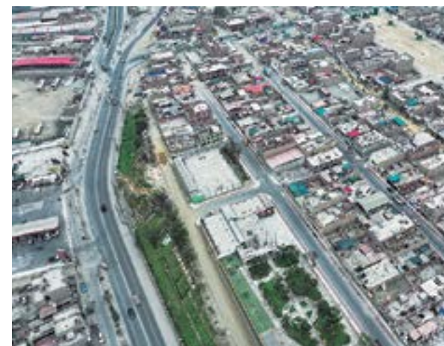
Obras de pistas y veredas en la Asociación de Vivienda Los Industriales y San Nicolás de Tolentino por inaugurarse en los próximos días.
