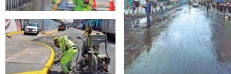
El mejoramiento del ornato de esta avenida, pistas y veredas, ahora se ve viable y limpia para la circulación de peatones y conductores.
