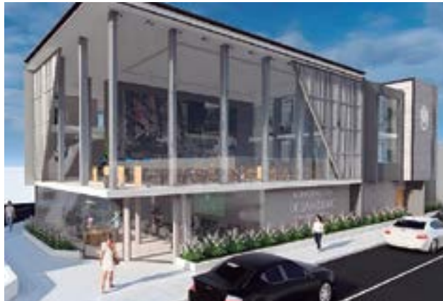
Se viene construyendo la nueva sede de seguridad ciudadana en la avenida Petit Thouars, que será una infraestructura moderna y tecnología de avanzada con el uso de la Inteligencia Artificial.
