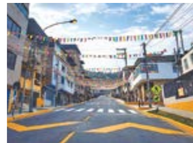
Primera pista de concreto en Flor de Amancaes de 1.2 km, vía moderna y segura.
