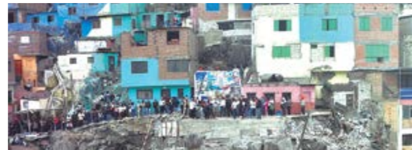
Tras 30 años de espera se hace realidad el muro de contención en la calle Montera del barrio de Leticia con balaustres coloniales.
