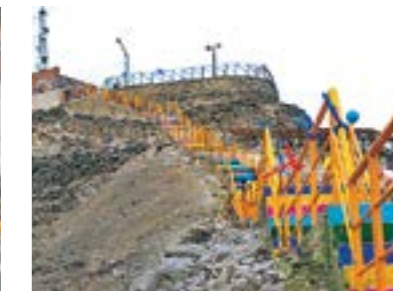
Escaleras con barandas, nuevo acceso peatonal al cerro San Cristóbal.
