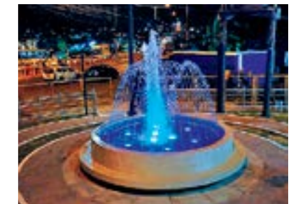
Construcción de pileta, recuperando un espacio que por años fue utilizado como vertedero.
