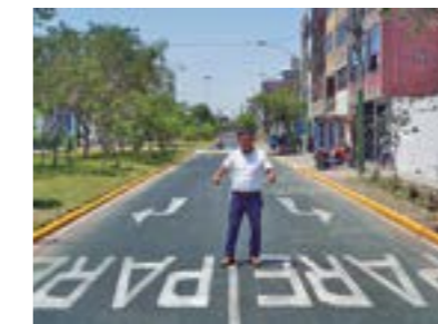
Mejoramiento de pista y vereda en el Jr. Ángel Valdez, tramo entre la calle Antón Sánchez y la Av. Alcázar.
