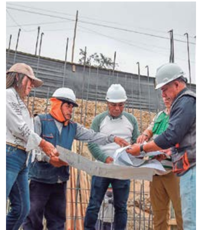
Alcalde supervisa avances de la Obra del Complejo Deportivo de La Ensenada.
