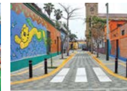
Sendero Turístico. Obra integral que conecta la zona este con la oeste de Barranco, pistas y veredas adoquinadas.
