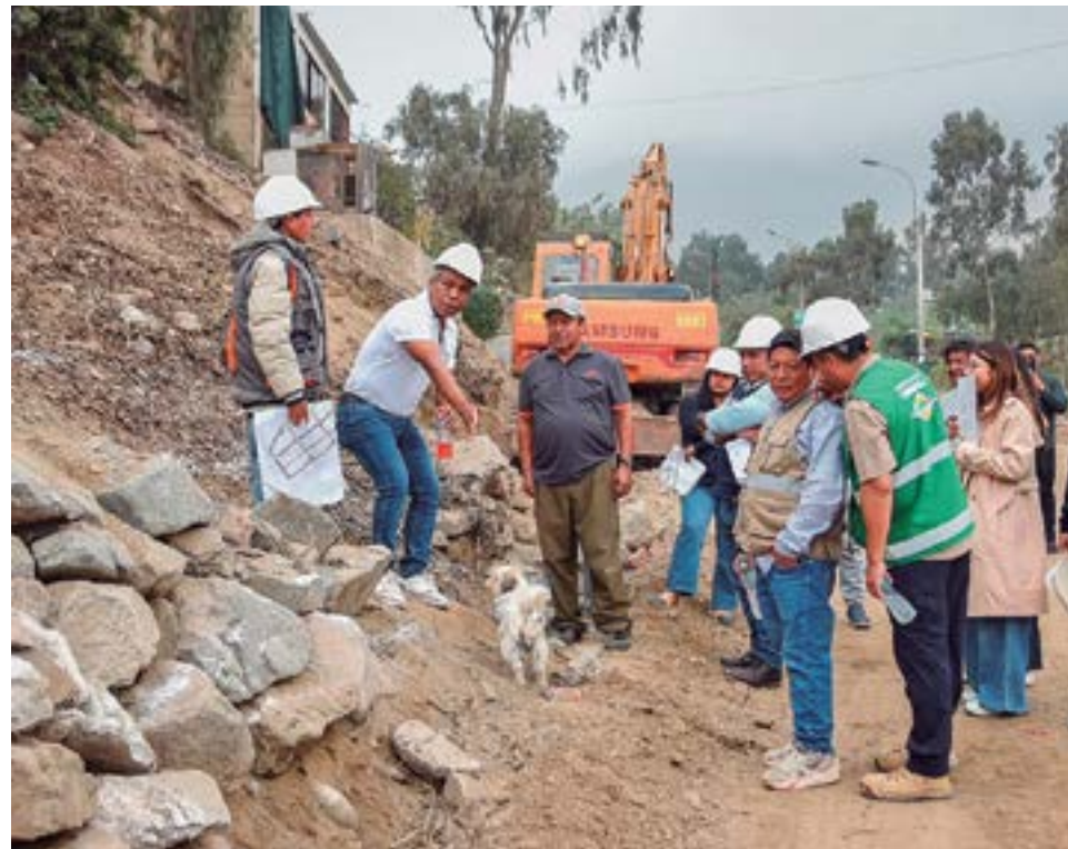
Alcalde supervisa trabajos en Villa Toledo.
