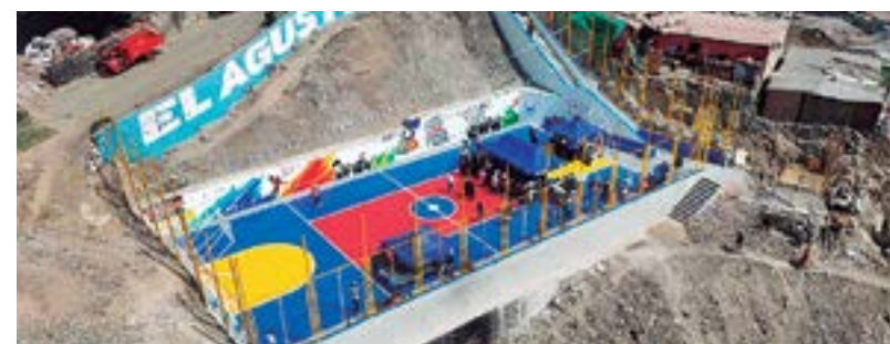
Losa deportiva A. H. El Independiente.
