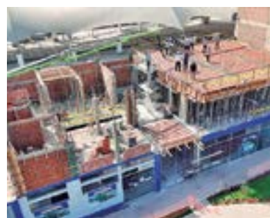
Avanza la construcción del segundo nivel de la Casa de Adulto Mayor.
