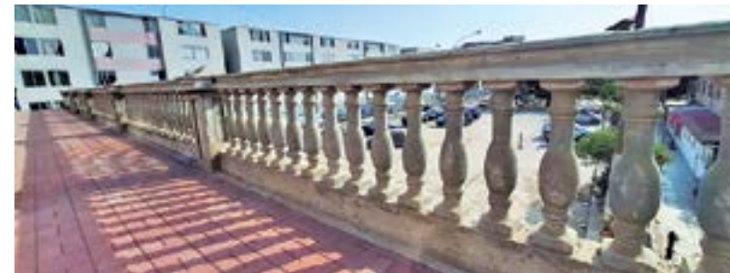
Muro de contención en Palomares cuenta con balaustres coloniales.
