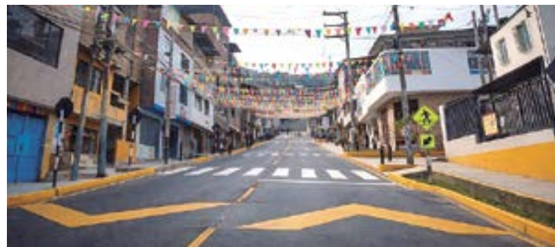
Pista de Flor de Amancaes de concreto, obra esperada por muchos años.
